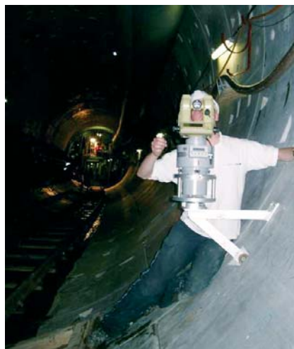
Bestimmen einer Orientierung direkt an der Tunnelbohrmaschine unter Tage. Die Messungen erfordern Geschick und manchmal auch etwas akrobatischen Einsatz.
